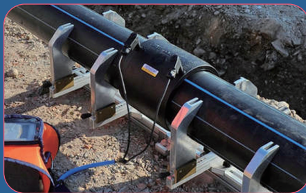
전자 융착 ELCTRO-FUSION WELDING
